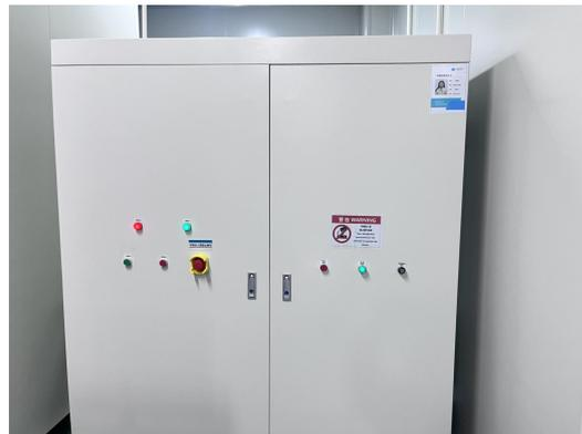
图 3-10 电控柜 X 射线钥匙开关、X 射线上电按钮、门机联锁复位按钮等
